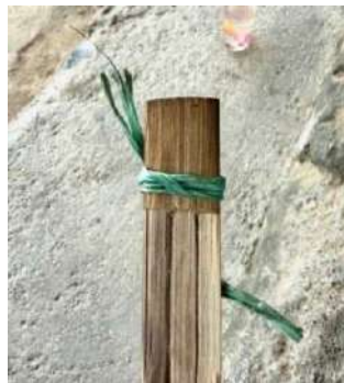
Gambar 10. Tali Rafia yang Digunakan Untuk Mengikat Bagian Otak Sumber. Dokumentasi Pribadi, Mei 2026
